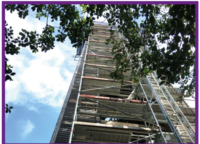
Nach Sturmschäden bekam der Klimaturm Friedenschöhe ein neues Dach.
