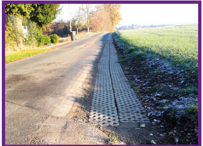
Verlegung von Rasengittersteinen zur Befestigung des Randstreifens an der Krebsheide in Sehlingdorf
