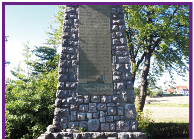
Sicherung des Ehrenmals in Holzhausen - Steine bröckeln aus der Fassade heraus. Das Denkmal wurde daraufhin mit Holzbohlen und Spanngurten gesichert. Ob ein Rückbau oder eine Sanierung erfolgt, wird im kommenden Jahr entschieden.
