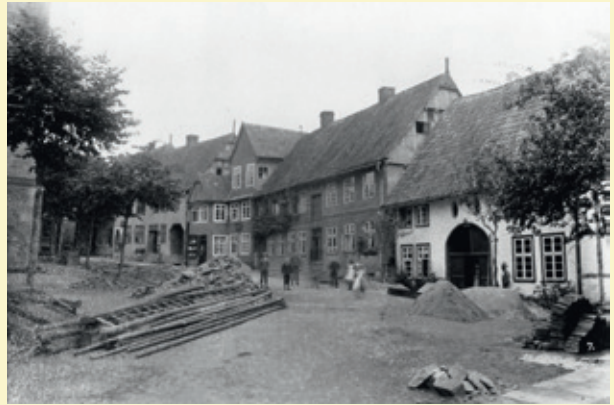
Der nördliche Teil der Kirchhofsburg, der sich nur wenig verändert hat. Ganz rechts das Haus Bornemann (früher Körner), dann die Häuser Meyerdrees und Döpke sowie Weymann
