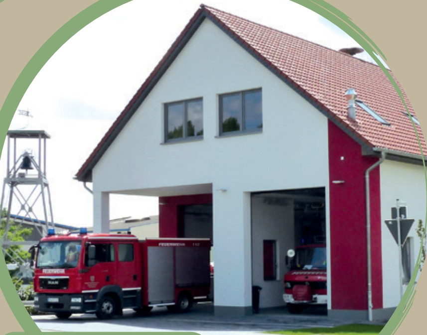
Neues Feuerwehrhaus in Tittingdorf
